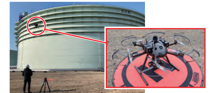
Trial testing oil tank inspection by drones (Tomakomai-Tobu National Petroleum Stockpiling Base) 石油タンクのドローン点検に係る実証実験 (苫小牧東部国家石油備蓄基地において)
